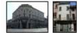
E - Ex Caserma Landucci H - Edificio rest. - comm.
