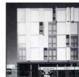
Esempio di rimodellazione della facciata realizzato a Muenz, dallo Nissen Wentzloff Architects, che utilizza pannelli fissi sulla muratura e pannelli a libro sulle aperture (vedi particolare a destra)
