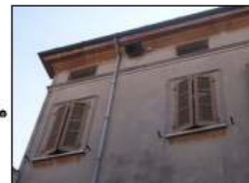
Ripensamento dell'illuminazione con sistemi innovativi ed energeticamente convenienti da sostituire ai fari collocati sotto la gronda degli edifici
