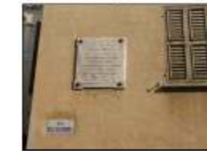
Palazzo Andreasi in fase di restauro
