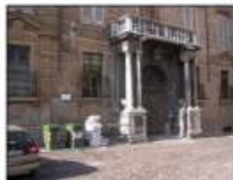
Presenza di casoneggi per lo spazzatura proprio in corrispondenza del portale di Palazzo Canossa, in affaccio su Piazza Canossa
