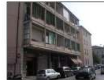
Esempio di rimodellazione della facciata che permette di mascherare edifici degli anni '60-'70 in cui il contenimento energetico non era una priorità
