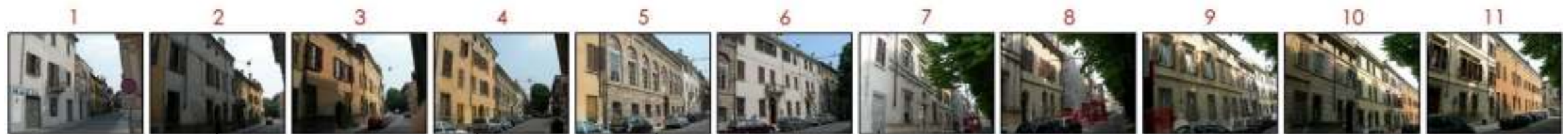
Buono stato di conservazione degli edifici che presentano due o tre piani
