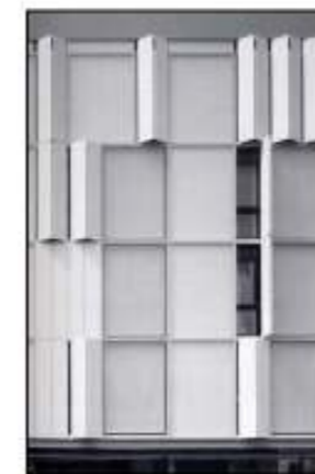
Esempio di rimodellazione della facciata realizzato a Muenz, dallo Nissen Wentzloff Architects, che utilizza pannelli fissi sulla muratura e pannelli a libro sulle aperture (vedi particolare a destra)
