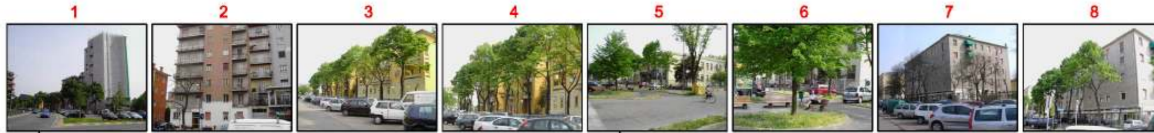
Edificio residenziale notevolmente alto che si affaccia su Piazza Antonio Gramsci
