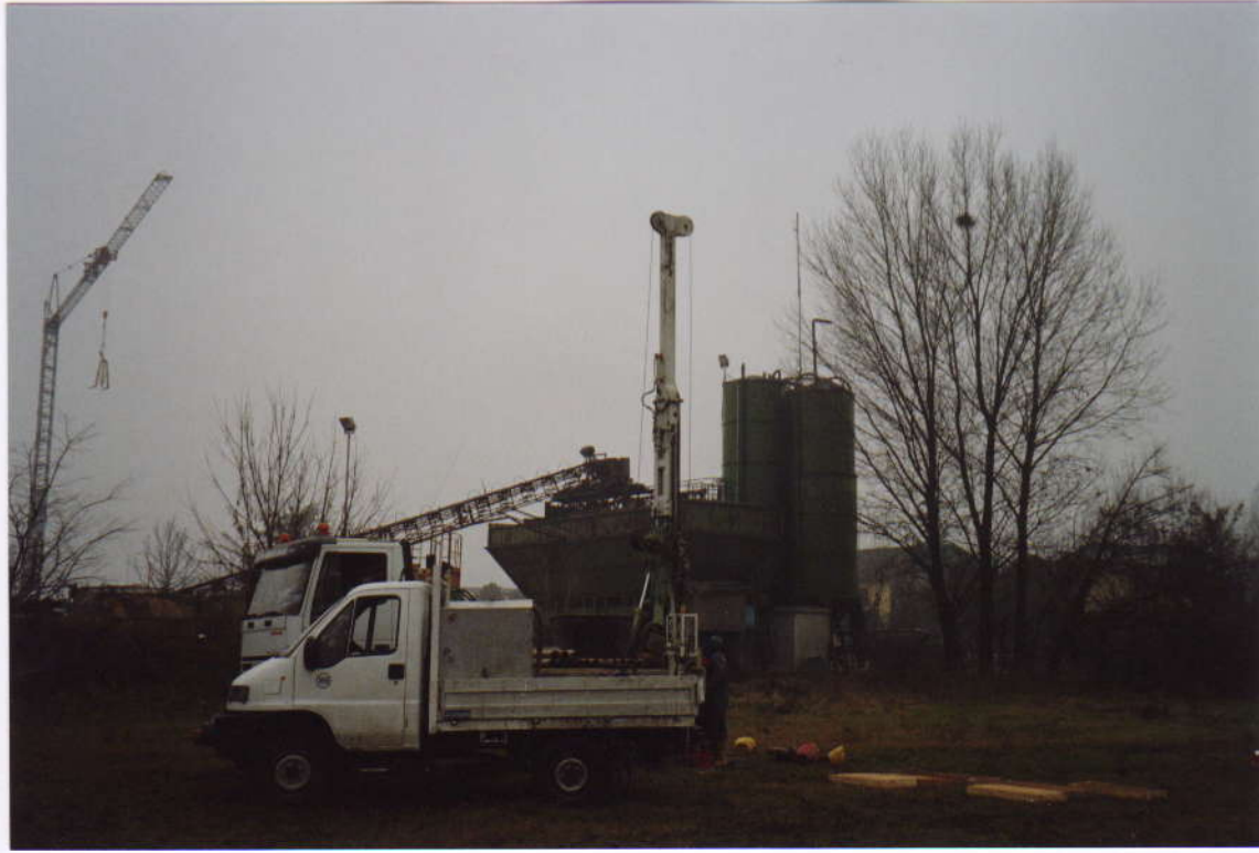
Foto 1 - Postazione del sondaggio S1: sullo sfondo il cantiere della Ditta "Monfardini".
