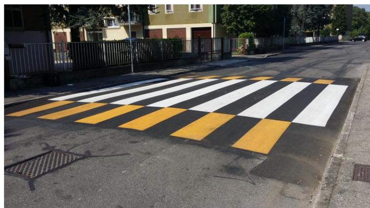
Figura 20 – tipologia di dosso in conglomerato bituminoso
