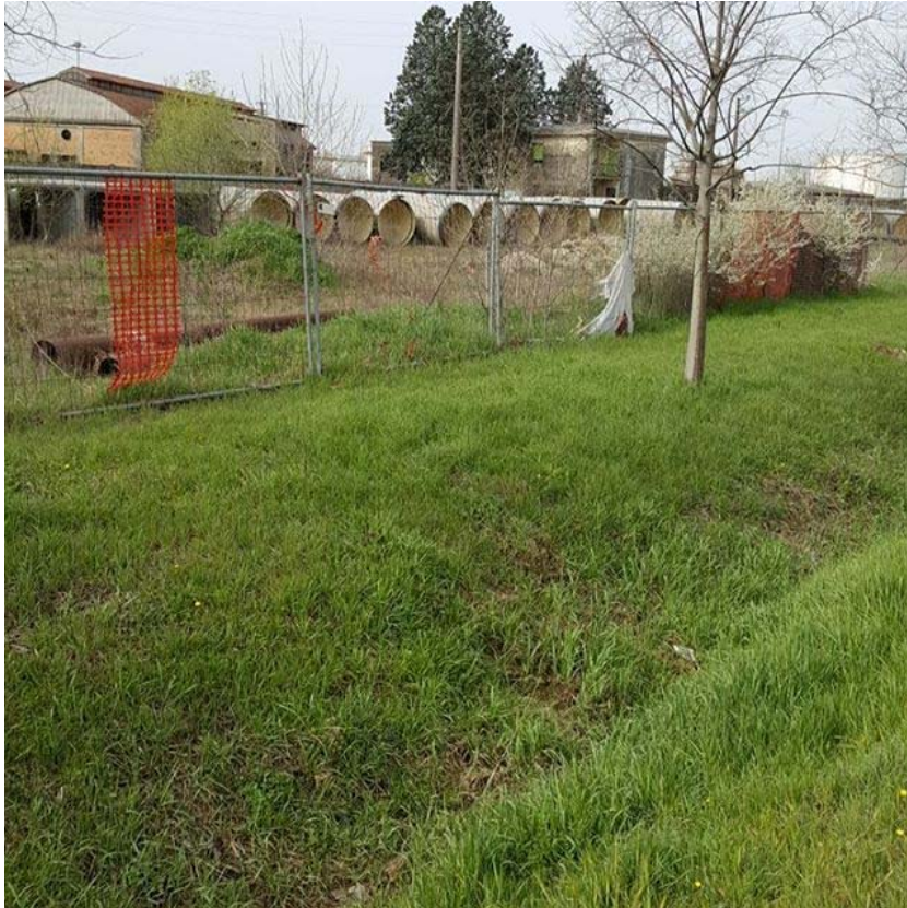
Figura A.4 – Tubi accatastati per il completamento del collettore di scarico
