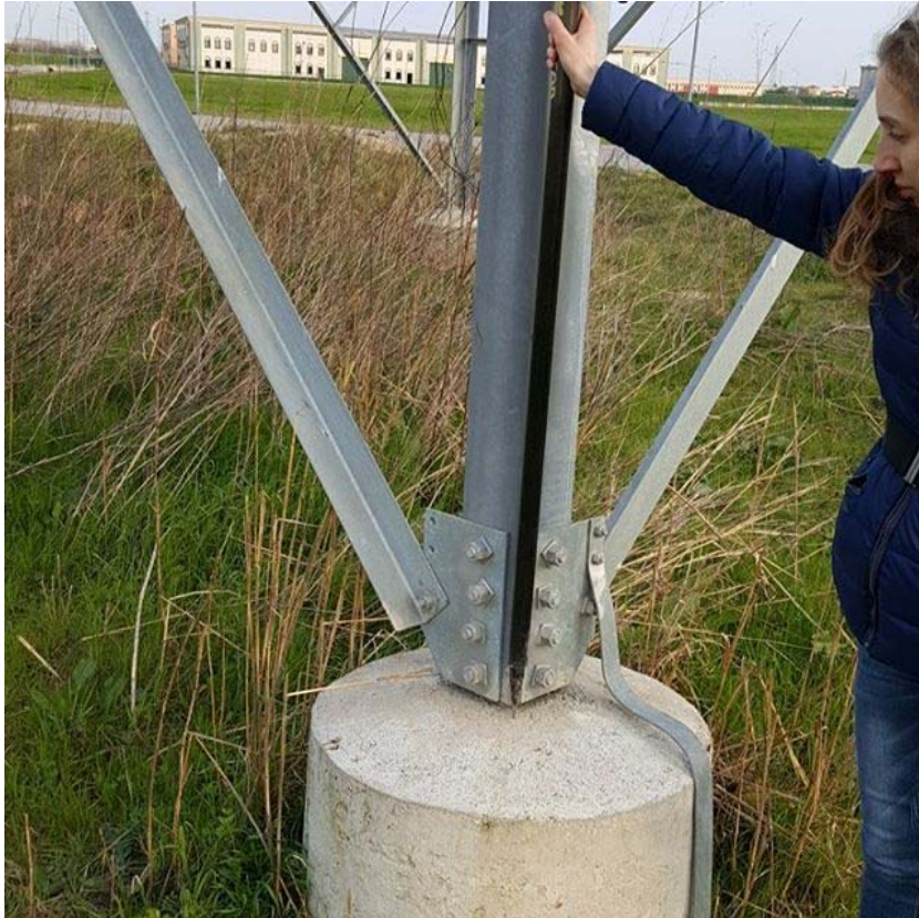
Figura A.6 – Caposaldo locale traliccio energia elettrica
