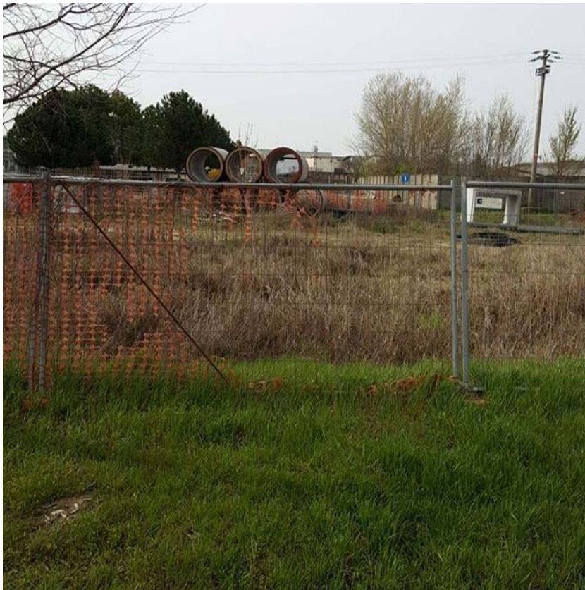
Figura A.5 – Tubi accatastati per il completamento del collettore di scarico
