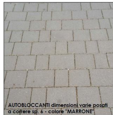
DETTAGLIO PAVIMENTAZIONE PERCORSI CICLOPEDONALI
